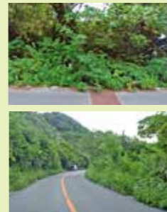
草が生い茂った道路
